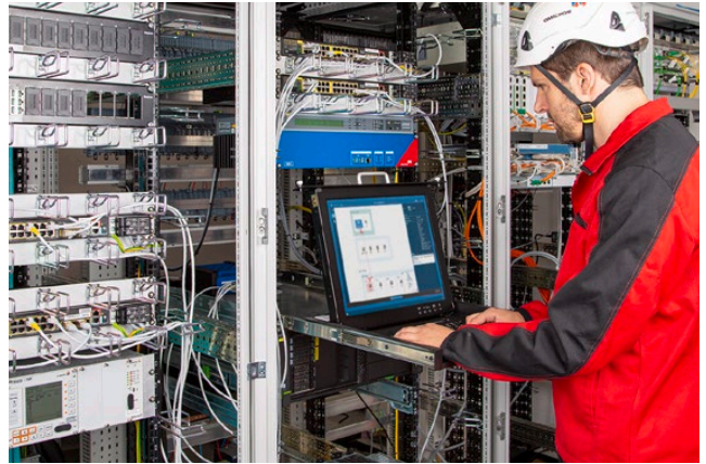
Figura 3: StationGuard importa el archivo SCL (System Configuration Language - lenguaje de configuración de subestaciones) de la subestación para crear un modelo completo del sistema
