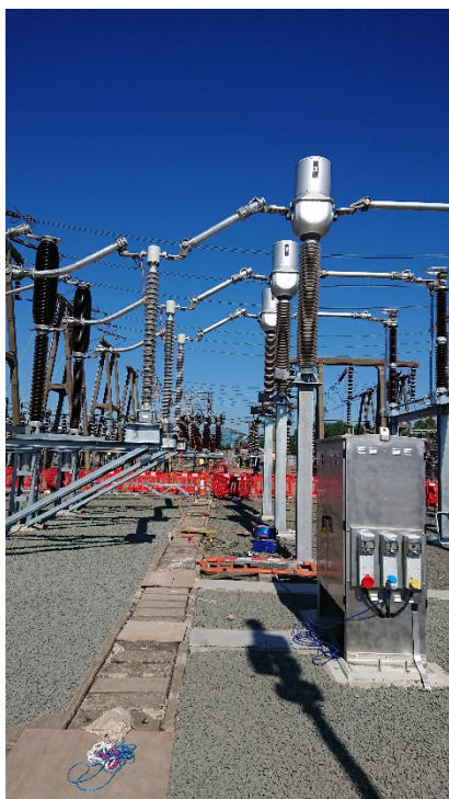
Abb. 7: Prüfung mit dem CPC 100, in der der Prüfstrom durch einen konventionellen und durch einen nicht konventionellen Wandler getrieben wird
