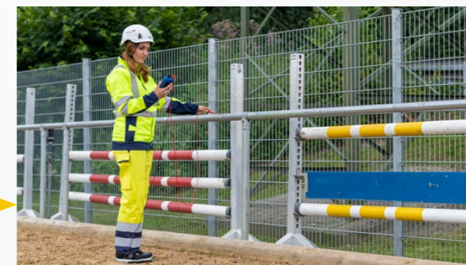
Mesure des tensions de pas et de contact à l'aide du voltmètre portable HGT1
