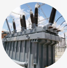
Силовые трансформаторы
