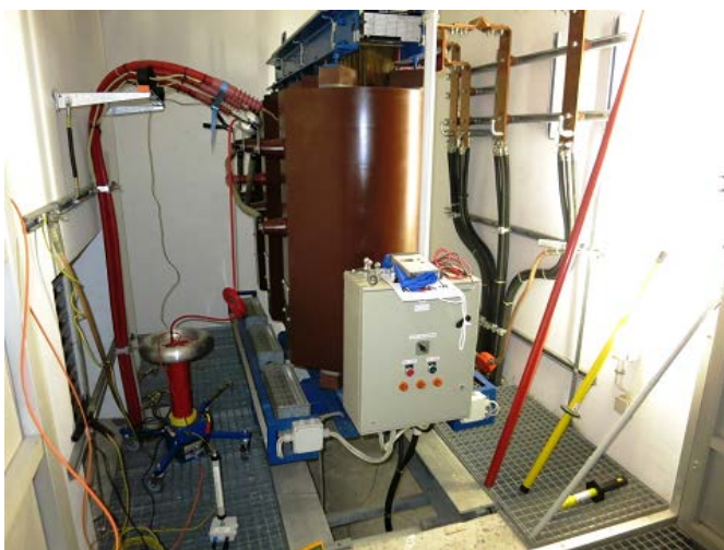
Abbildung 9. Prüfanordnung der TE-Messung an einem 20-kV-/2-MVA-Gießharztransformator
