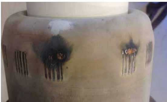
Funkenüberschlag im Hauptkontaktträger aufgrund loser Teile.
