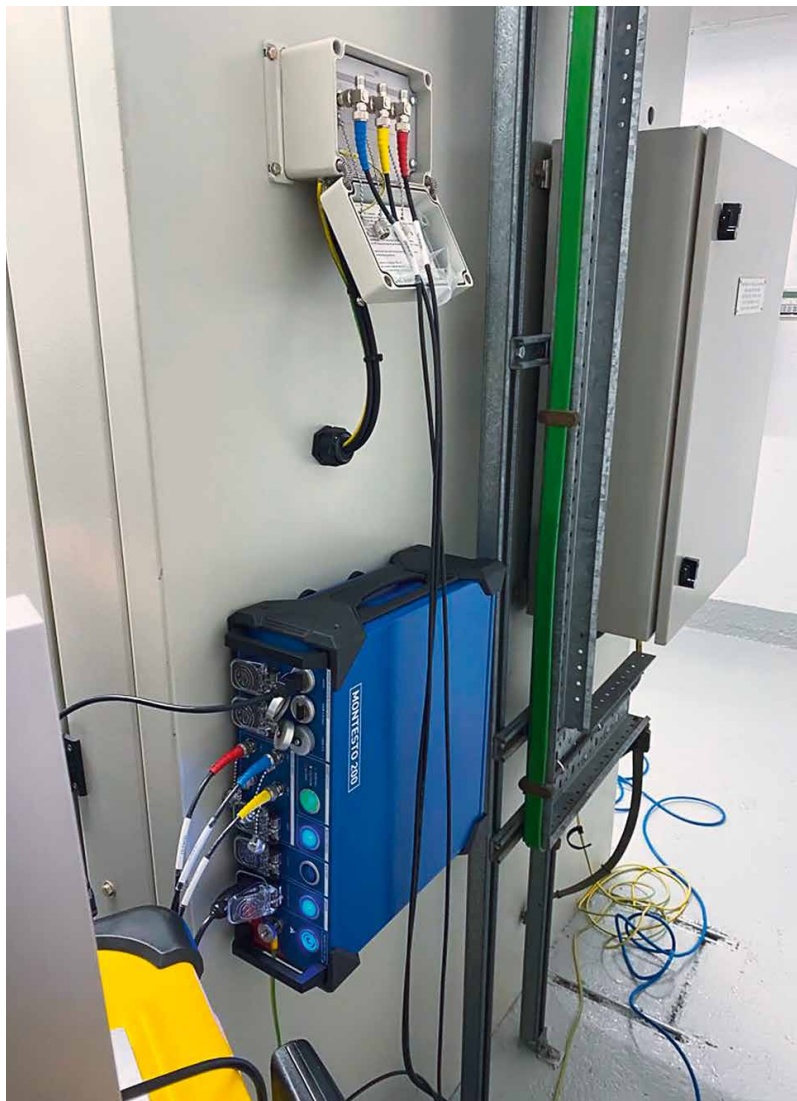
El sistema MONTTESTO 200 puede montarse fácilmente en el activo para el monitoreo en línea de DP durante períodos más largos.
