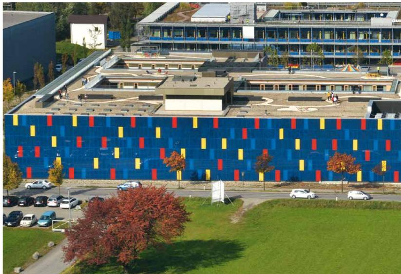
Se han instalado 780 m<sup>2</sup> de placas fotovoltaicas en el exterior de la oficina central de OMICRON en Klaus.
