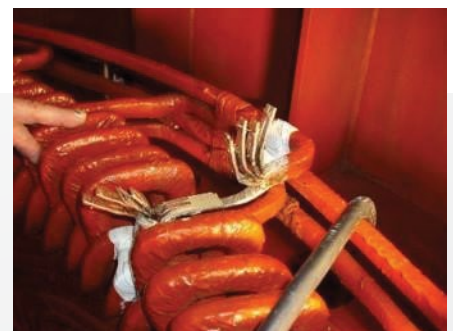
Reparatur der defekten Lötstelle
