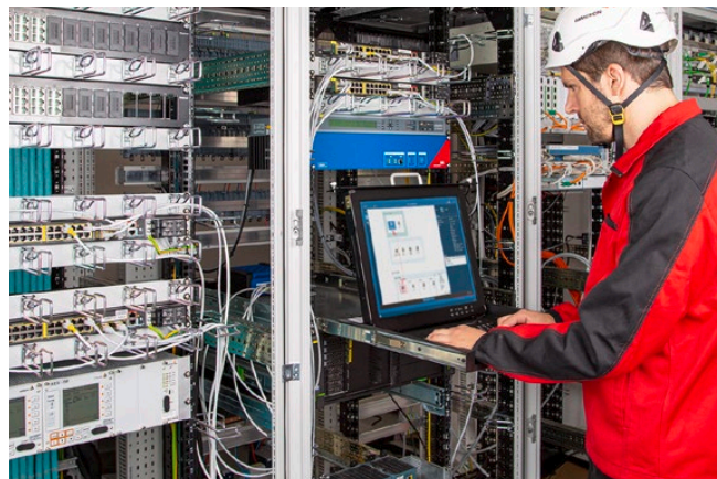
Рис. 3. Система StationGuard импортирует файл SCL с описанием подстанции для создания полной модели системы
