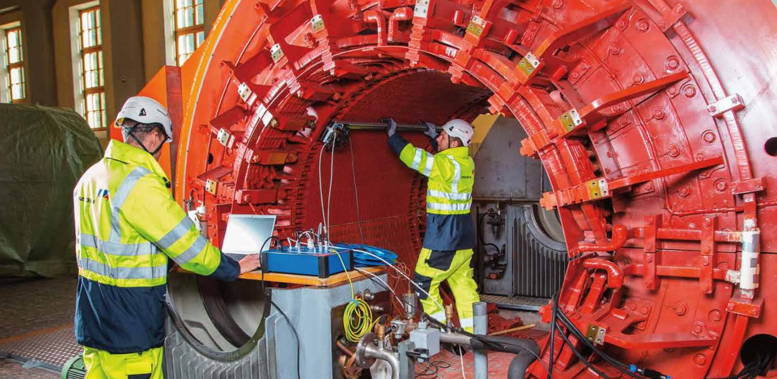
Por último, nos gustaría tratar el área final del núcleo laminado que está especialmente clasificado para los turbogeneradores. En este caso, así como en otros casos especiales, la solución permite desacoplar la bobina Rogowski del carril y posicionar el sensor manualmente. ■
