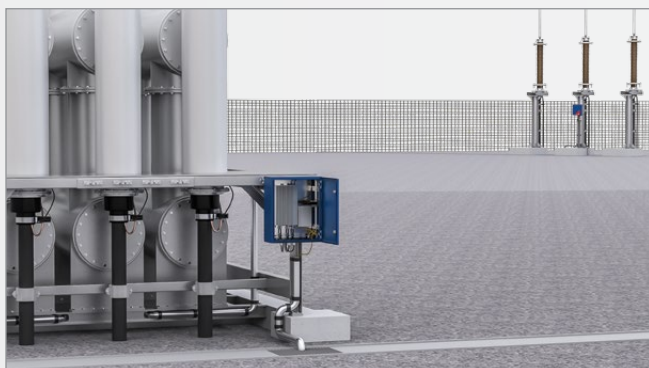
Surveillance des DP au niveau des extrémités de câble
