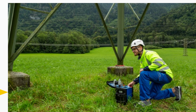
Pomiar rezystywności gruntu
